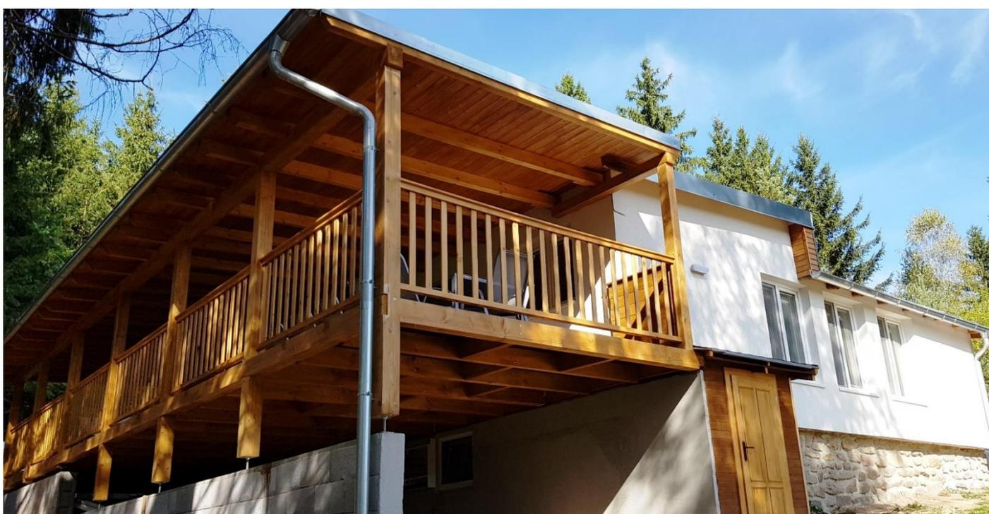
Ansicht nach der Renovation und Ausbau. Alle Fenster sind durch gut isolierende Schweizer Fenster ersetzt und die Wände wurden innen komplett neu gebaut mit starker Isolation. Das ganze Haus ist somit energetisch optimal. Unter der Terrasse ist 9.5x3.8 m Parkplatz für 2 Auto und Fahrräder.
